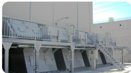
水処理場向／除塵機
